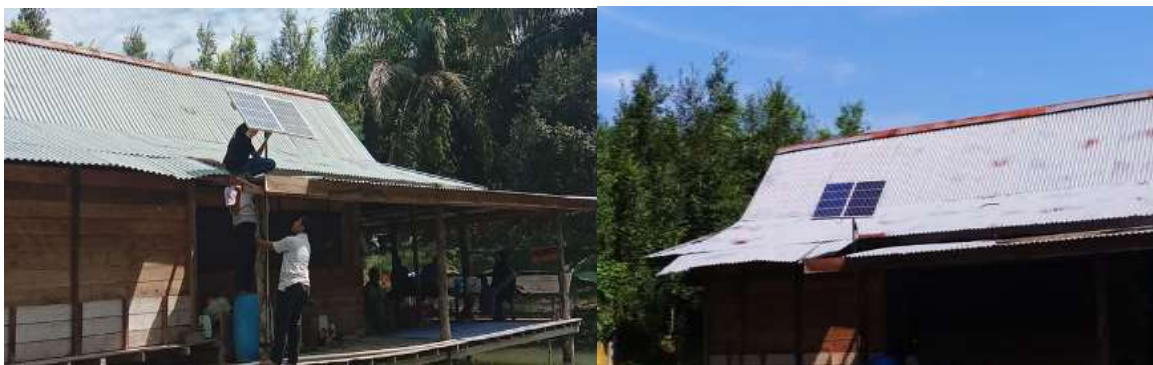
Gambar 2. Pemasangan solar panel dikawasan perkebunan petani serai wangi
